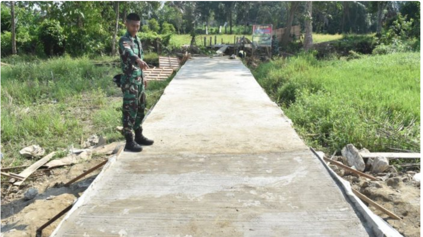
Gorong-gorong dan Slop Beton Rampung Seratus Persen
