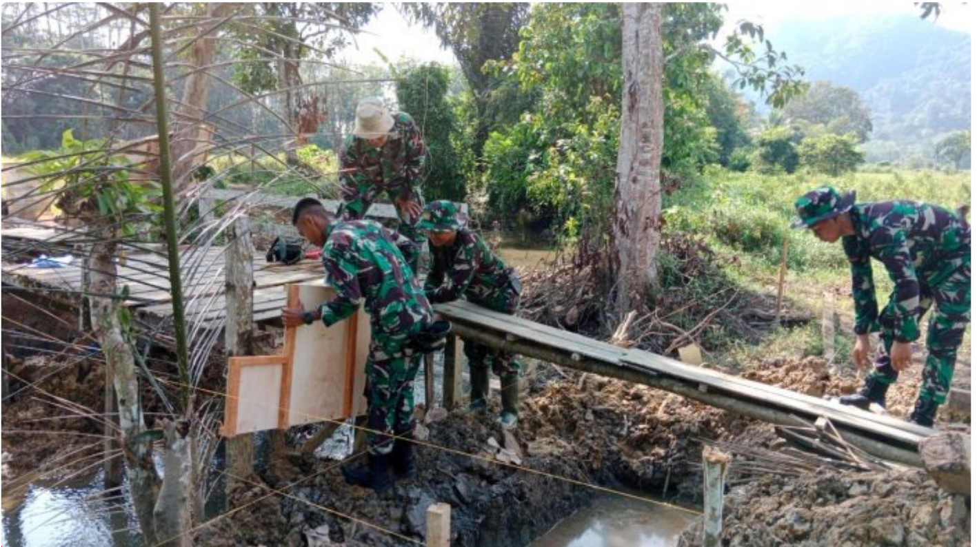
Satgas TMMMD ke-116 Kodim 1002/HST Dikerjakan Jembatan
